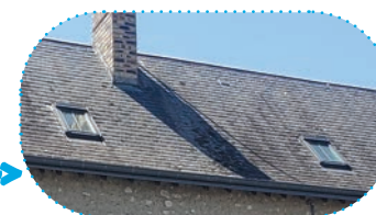
Travaux à l'étage : changement velux à l'arrière toiture....
