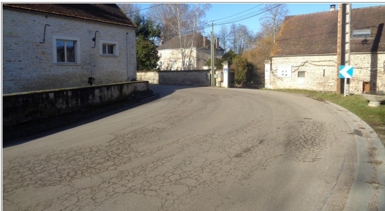
**Remarque** : la chaussée étant totalement faïencée dans le virage, une reprise de la structure s'avère nécessaire.
