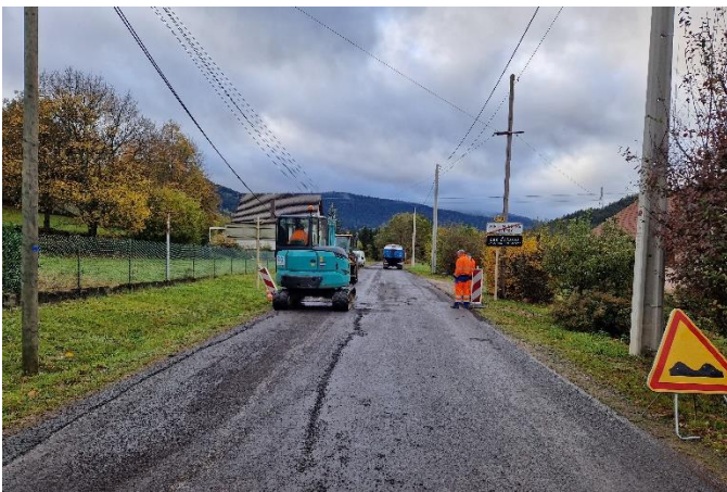
8 novembre : travaux de voirie sur la RD73
