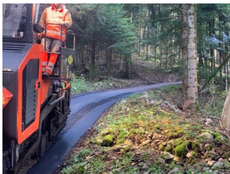
22 novembre : Travaux de voirie au lieu-dit Les Evaux.
