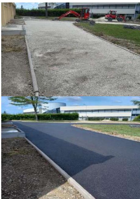
Accessibilité – Ad'AP des gymnases Jean Jaurès et Givry en Argonne
