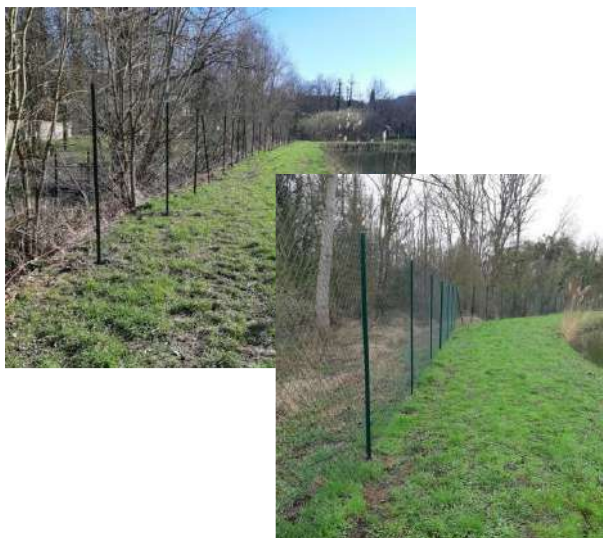
Remplacement du grillage de la station de traitement des eaux usées Givry en Argonne 58 250.19 €TTC
