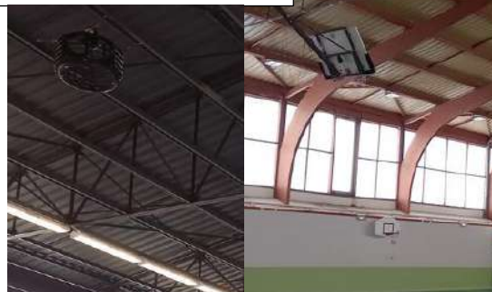
Installation de destratificateurs d'air dans les gymnases de la collectivité et l'Aquarelle Entièrement financé par Les Certificats d'Energie Economiques
