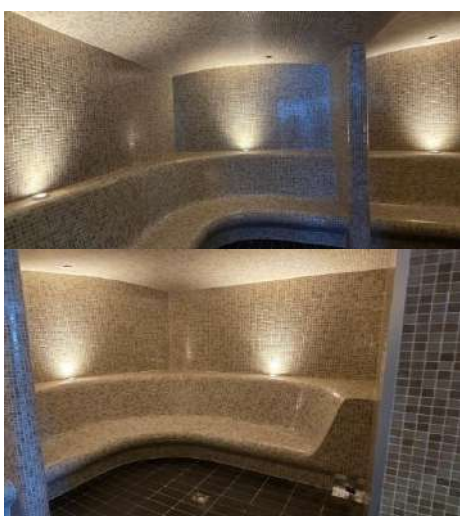
Préparation intervention pour remplacement des carrelages/faïence du Hammam de l'Aquarelle
