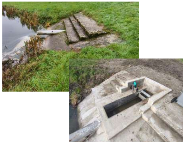
Mise en place d'un canal de comptage et d'un dégrilleur en amont de la station + réhabilitation du canal en aval de la station de traitement des eaux usées de la commune La Grange aux Bois 54 730.80 €TTC
